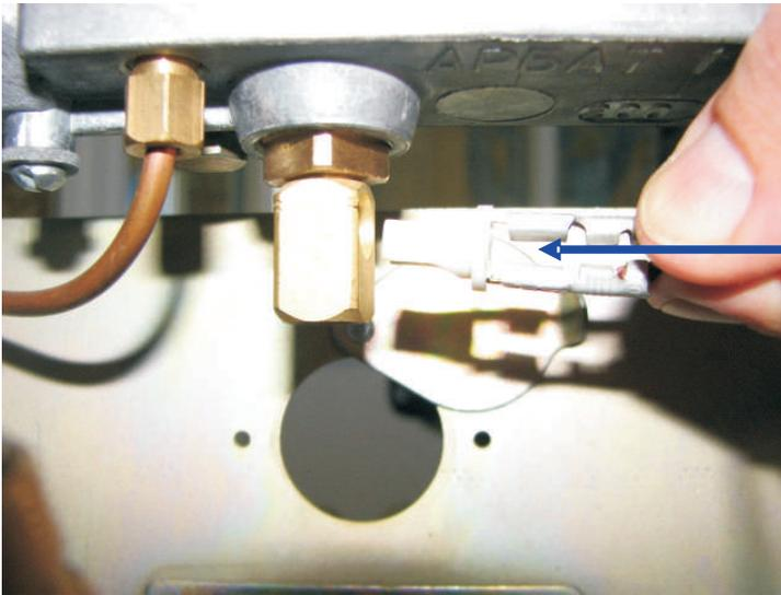
Вынимаем колодку тягопрерывателя
