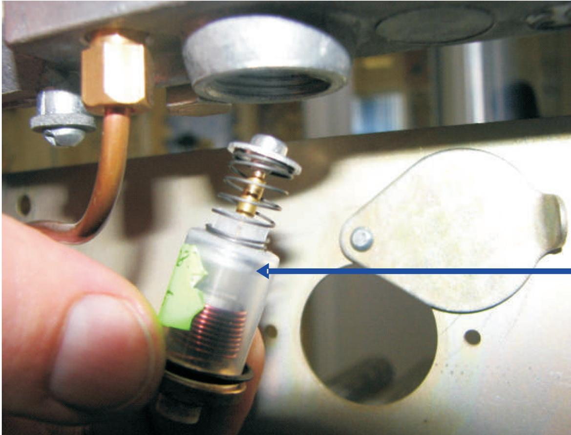
Вынимаем магнитную пробку
