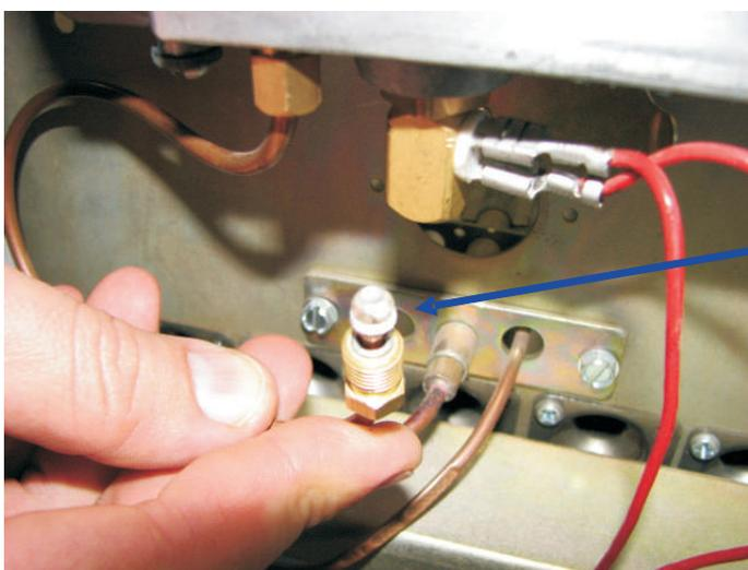
Откручиваем и снимаем термодатчик
